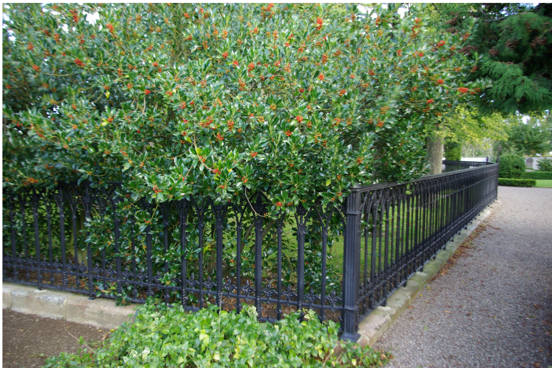
Kristorn indenfor støbejernsgitteret mod øst. Bemærk den smukke granitstensmur som er sokkel for støbejernsgitteret for at få et plant gravstedsareal.
